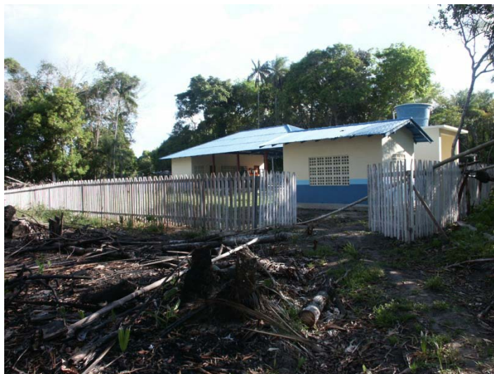
Figure 23 - Unidade de beneficiamento abandonada (instalações disponibilizadas pelo poder público).
