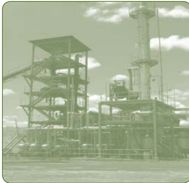
Planta-piloto de Dedini para la producción de etanol en base al bagazo.
