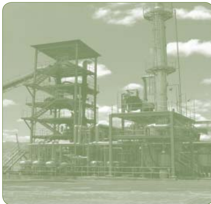
Planta-piloto da Dedini para a produção de etanol com base no bagaço.
