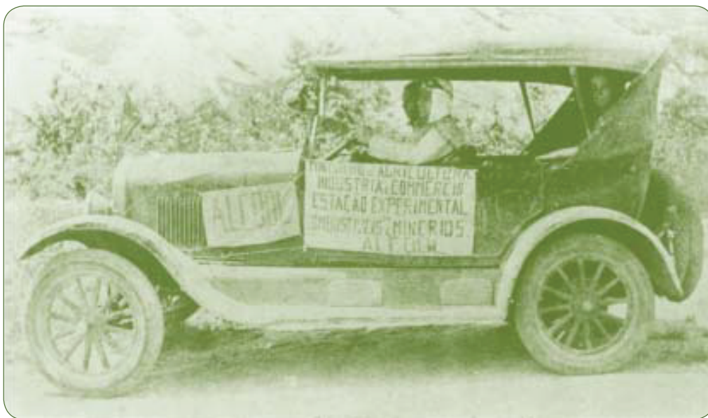
Veículo Ford adaptado pelo INT em 1925 para demonstrações do uso de bioetanol puro como combustível.
