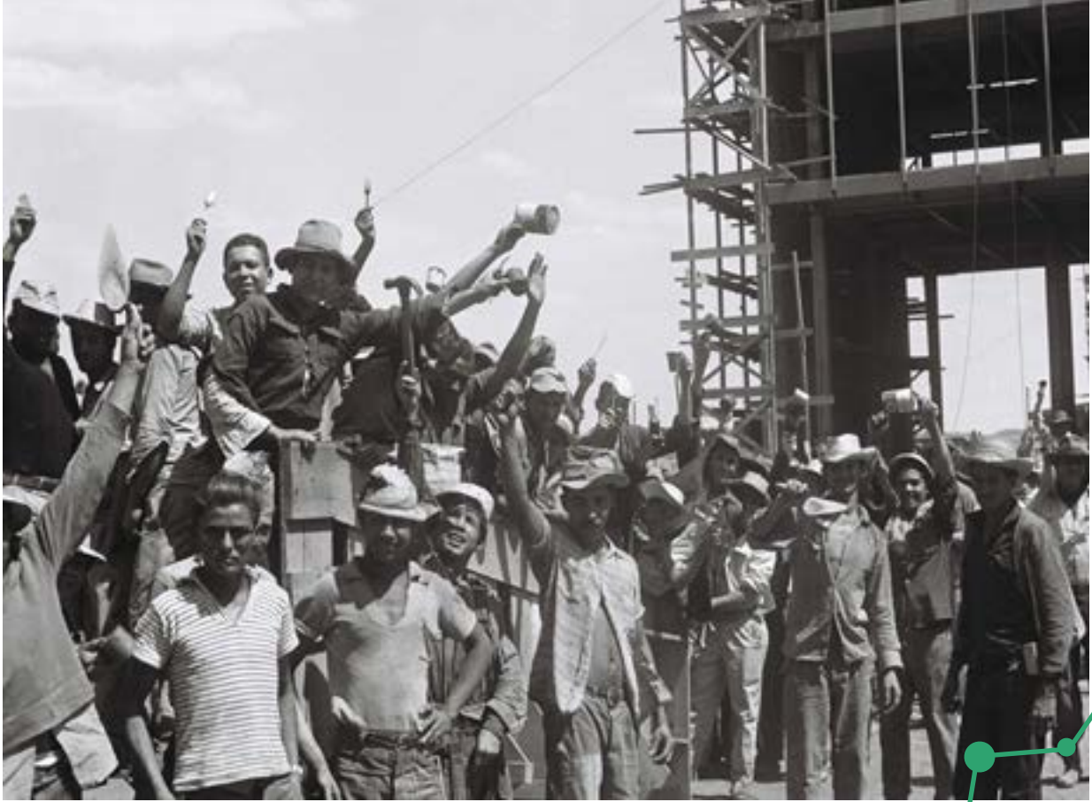
Canteiro de Obras da construção de Brasília Brasília - DF
