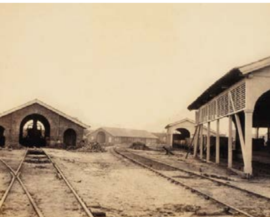
Construção Estrada de Ferro do Recife ao São Francisco 1858-1860
