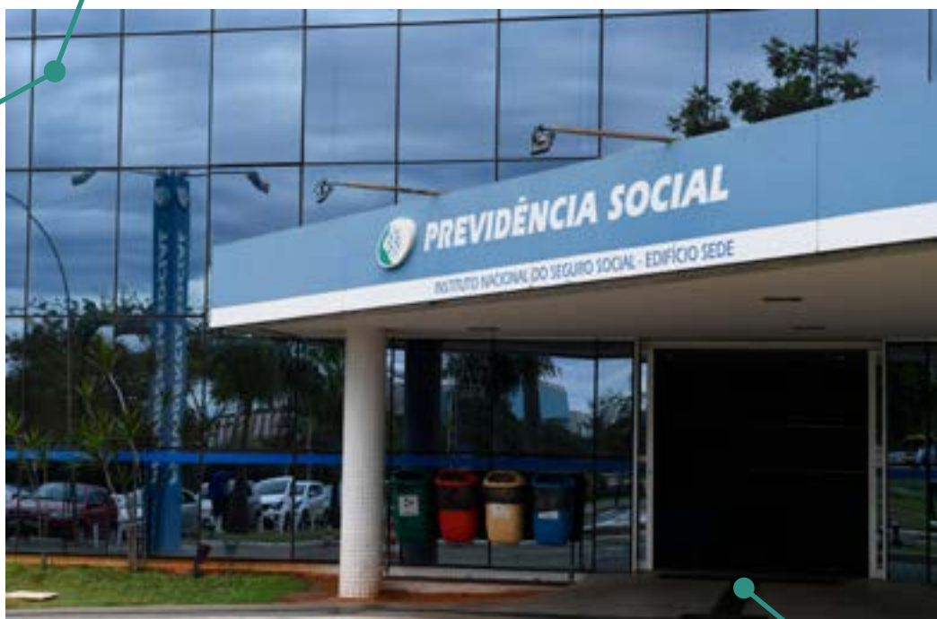
Fachada do Edifício Sede do INSS
