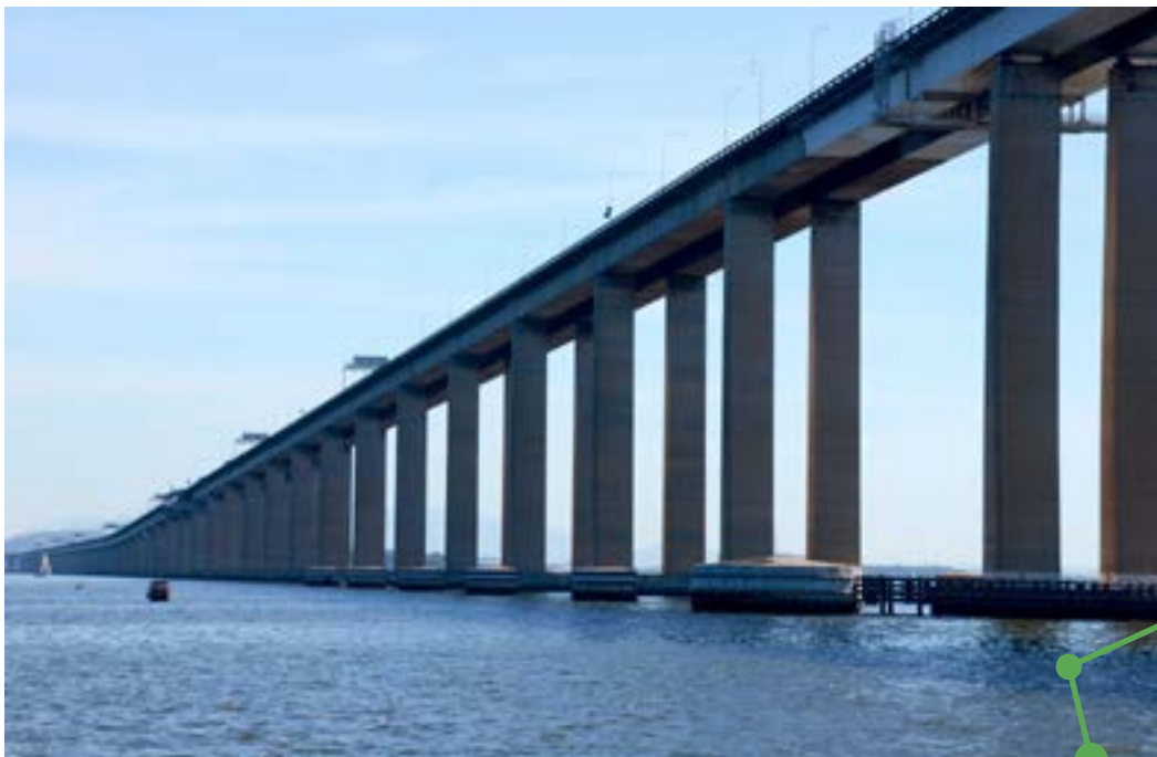
Ponte Rio-Niterói Rio de Janeiro, 2017
