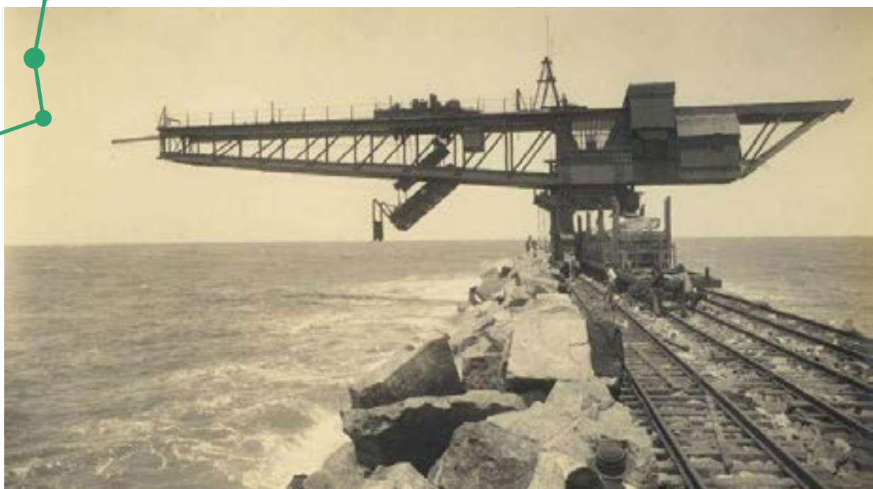
Construção dos Molhes da Barra Rio Grande do Sul, 1911-15
