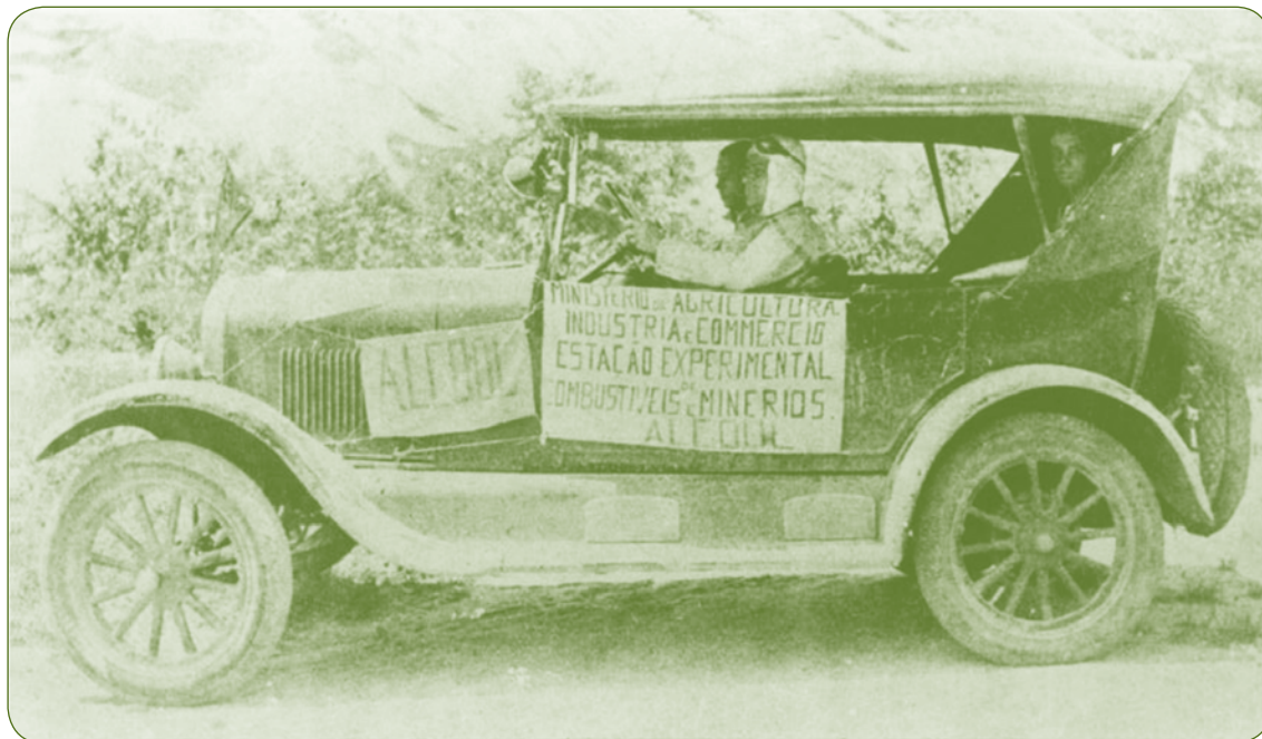
Véhicule Ford adapté par l'INT en 1925 pour démontrer l'utilisation du bioéthanol pur comme combustible.
