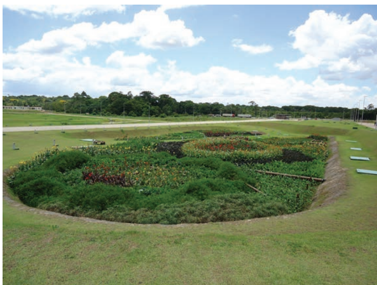
Foto 2. Jardim filtrante no Ecoparque da Natura, em Benevides, Pará
