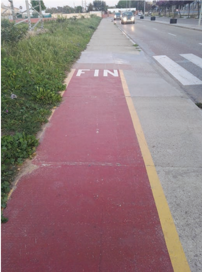
Foto 5. Separación inadecuada del carril para bicicletas
