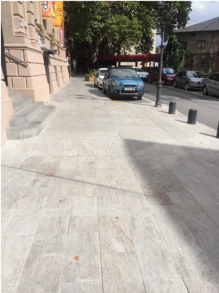
Foto 20. Piezas Rushmore instaladas en espacio urbano
