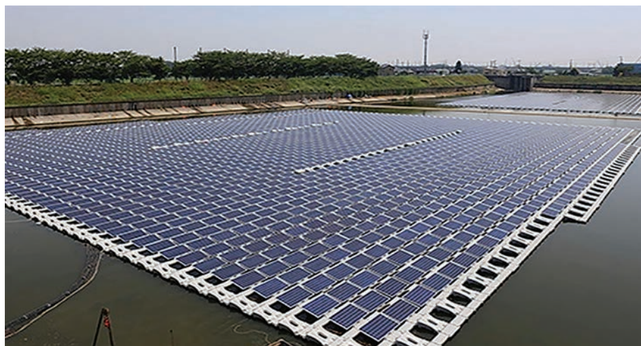
Foto 1. Painéis fotovoltaicos flutuantes no reservatório de uma UHE
