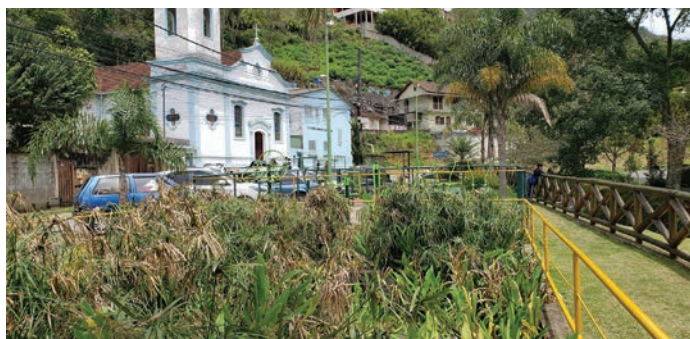
Foto 5. Vista da zona de raízes com parquinho e, ao fundo, a escola (em azul) que recebe o gás canalizado por baixo da rua
