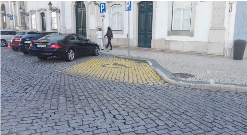
Foto 2. Pavimento irregular de adoquines
