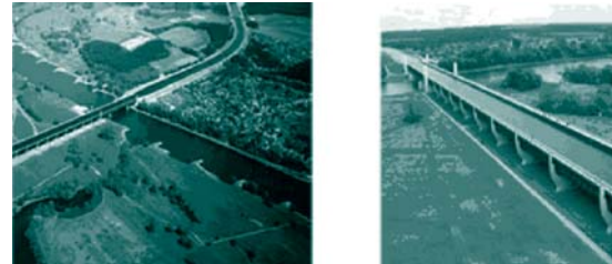
Figura 2-10: Canal/ponte sobre o Rio Elba
