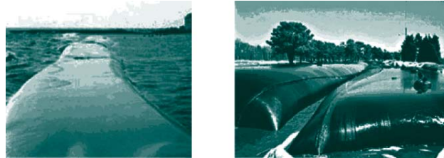
Figura 2-7: Espigões construídos com tecido geotextil (geotubes)
