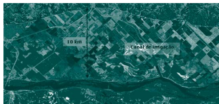
Figura 2-14: Intervenções no leito do Rio Mississippi (St Louis)
