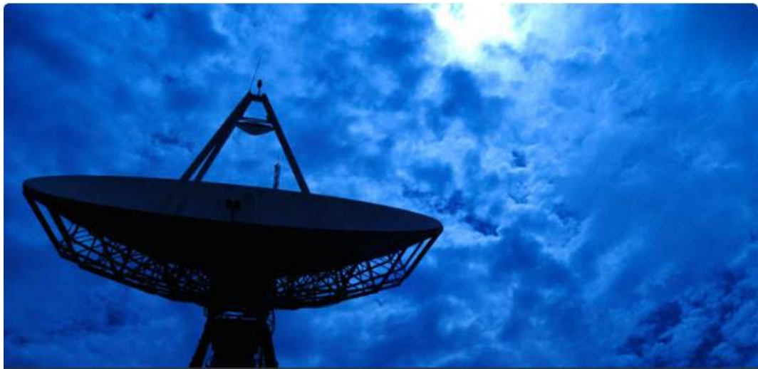
(b) Antena da estação terrena de Cuiabá, MT.
