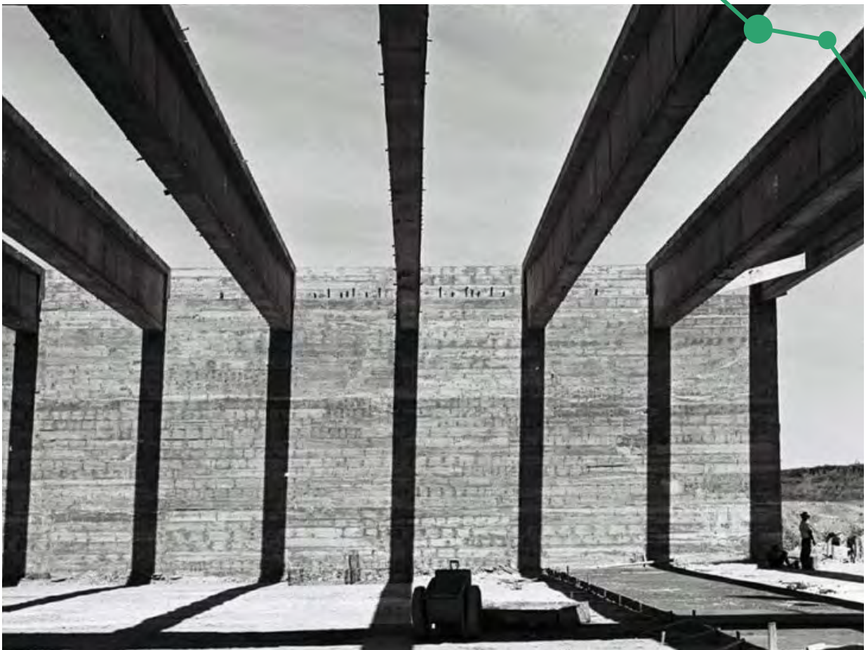
Obras sob a rodoviária do Plano Piloto de Brasília Brasília - DF
