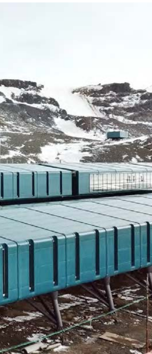
Estação Antártica Mar 2019
