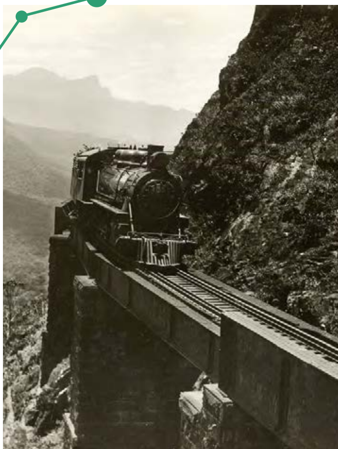
Viaduto do Carvalho, Estrada de ferro Curitiba-Paranaguá Paraná, 1928
