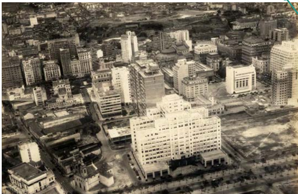
Vista Aérea do Edifício do Ministério do Trabalho
