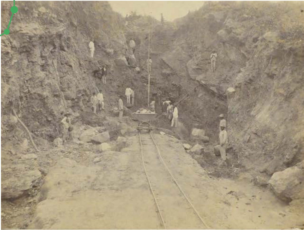
Fotografia de trabalhadores da Inspetoria de Obras con- tra as Secas na construção do açude Acarape no Ceará. Ceará, 1910
