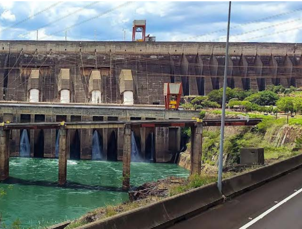
Usina Hidrelétrica de Itaipu Foz do Iguaçu - PR, 2022
