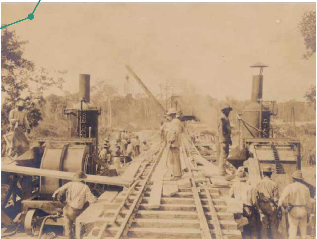
Obras de construção da Via Férrea - Estrada de Ferro Madeira-Mamoré Rondônia - RO, 1910
