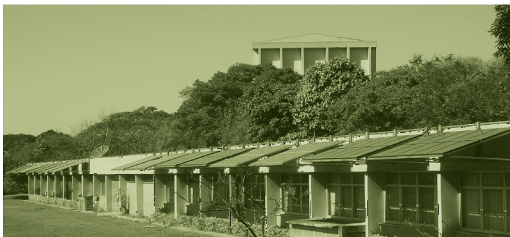
Figura 4: Sistema fotovoltaico de 12 kW conectado à rede em operação no prédio da administração do Instituto de Eletrotécnica e Energia da Universidade de São Paulo.
