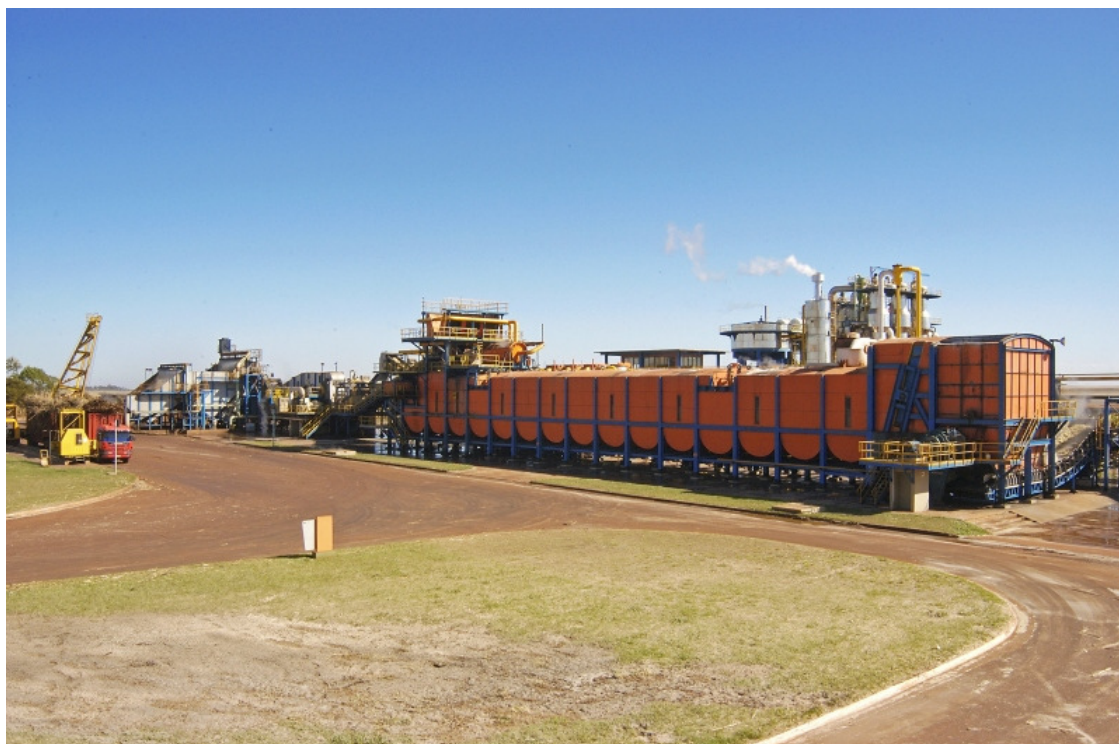
Figura 19: Difusor instalado em usina brasileira (Sermatec, 2008)
