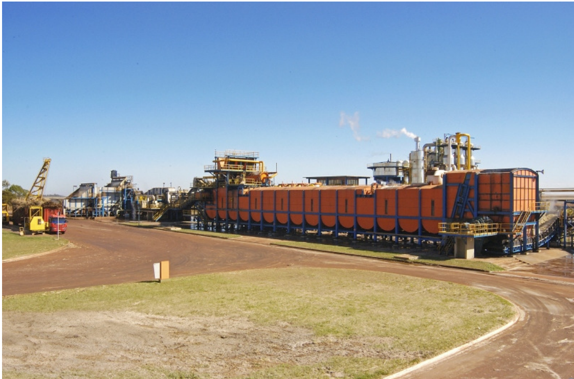
Figura 19: Difusor instalado em usina brasileira (Sermatec, 2008)
