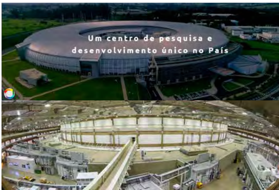
Figura 2.10 – Sirius, a fonte brasileira de luz síncrotron (parte superior) e uma visão interna (parte inferior)
