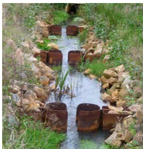
Fishflowforms, criados para passagem de peixes https://www.antroposofiemagazine.nl/uitgelicht/flowform-stroming/
