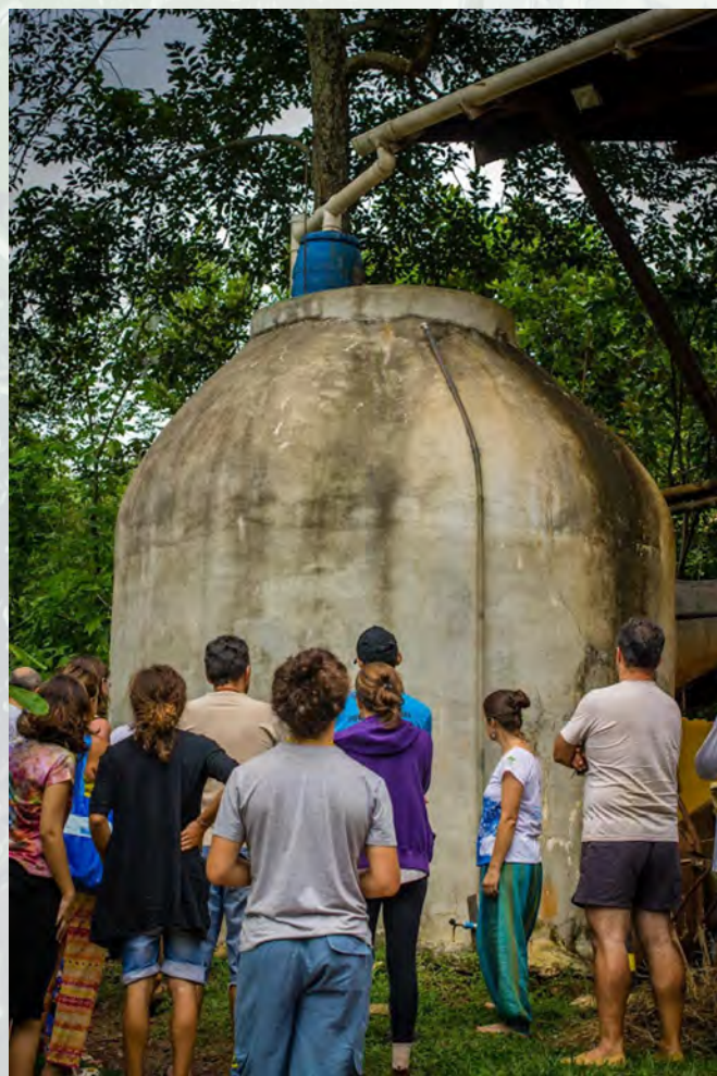
Cisterna em Ferrocimento - Estação de Permacultura Nós na Teia - DF https://sitionosnateia.com.br
