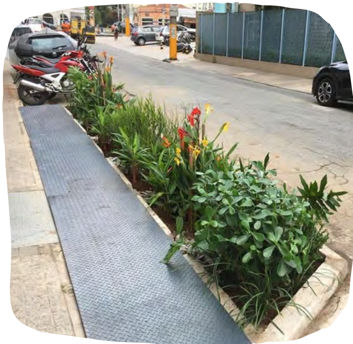
Jardim de chuva em SP, recebe escoamento superficial da rua http://verdesp.com.br/jardim-de-chuva/
