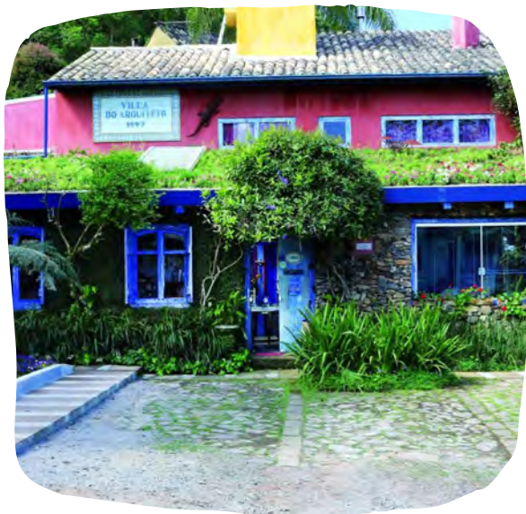
Telhado vivo - SP
